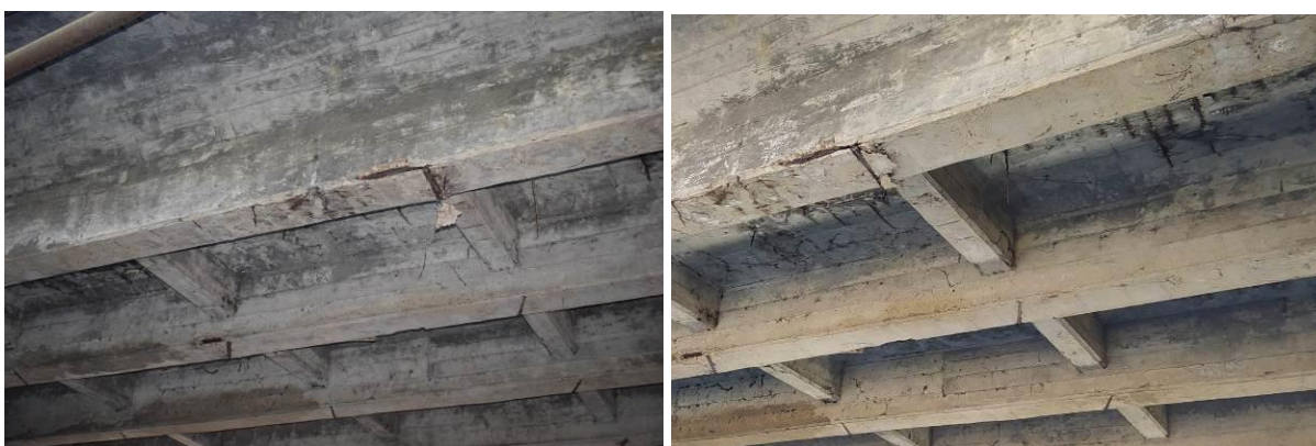
Fot. 9 i 10 Widok od strony wody dolnej rzeki Mroźnicy – stan techniczny dźwigarów i płyty pomostowej
