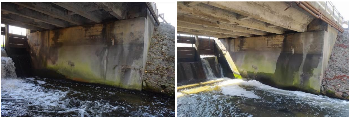
Fot. 7 i 8 Widok od strony wody dolnej rzeki Mroźnicy – stan techniczny przyczółka od strony m. Łódź
