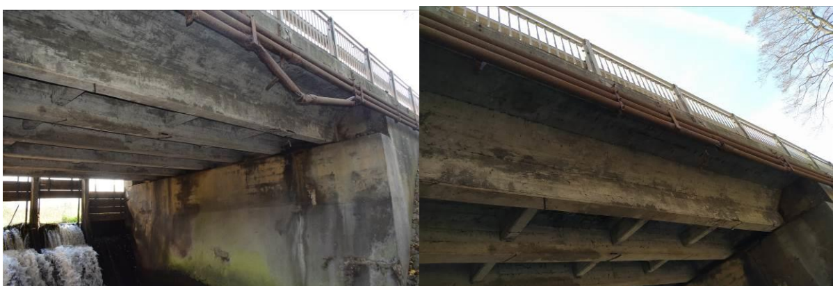
Fot. 11 i 12 Widok od strony wody dolnej rzeki Mroźnicy – stan techniczny rur osłonowych instalacji obcych na obiekcie
